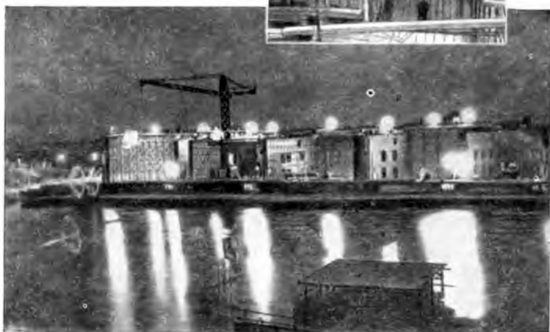
Строительство баз подводных лодок в портах Франции. Эти базы имели гигантские укрытия, обеспечивавшие подводным лодкам полную безопасность от вражеских бомб. Толщина железобетонных перекрытий равнялась 4 м.
